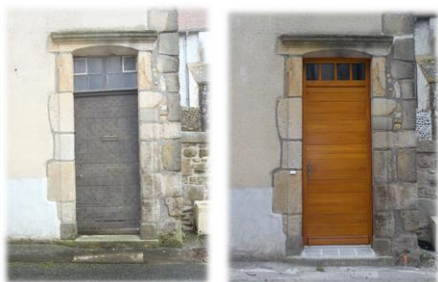
Remplacement de la porte d'entrée
